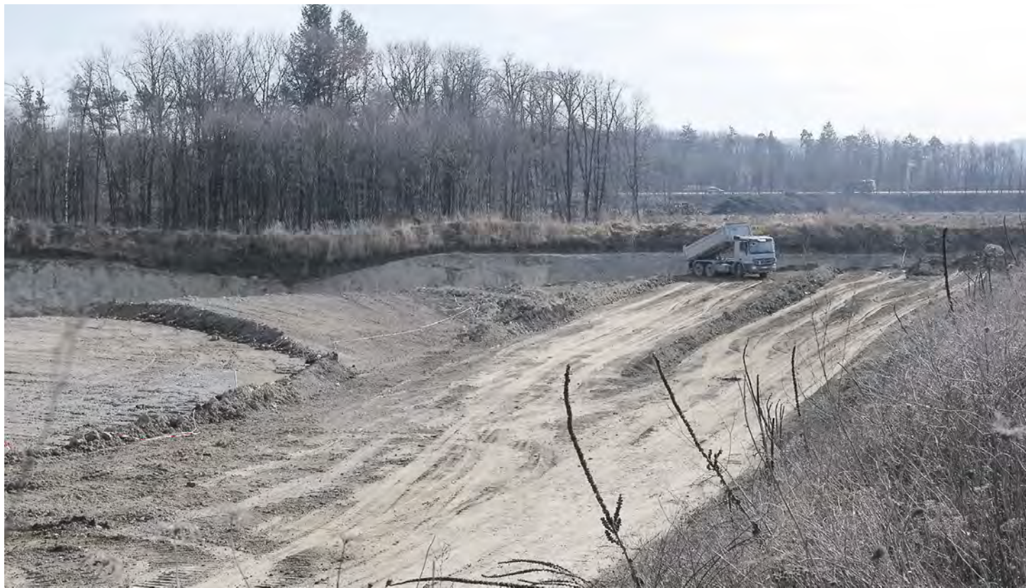
Im „Stockfeld“ sind bereits Renaturierungsarbeiten im Gange, im Hintergrund soll es weitergehen mit dem Kiesabbau bis zur B 33 neu, die durch die jetzt vorgenommenen Baumfällungen schon sichtbar ist. sub-Bild: of
