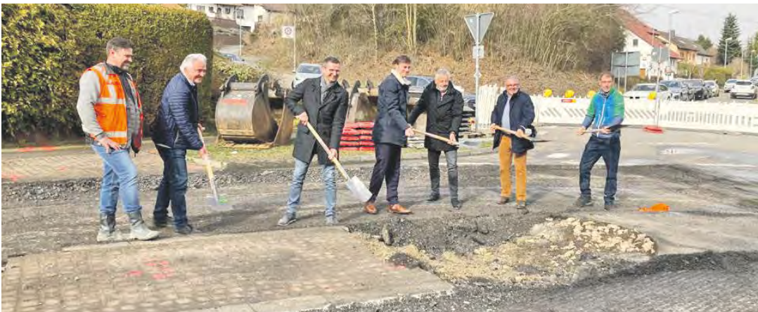
Auf dem Bild sind von links: Günter Feuerstein, Fa. Strabag; Andreas Broß, Ing. Büro Reckmann; Bürgermeister Patrick Stärk; Landrat Zeno Danner; Eike Reckmann, Ing. Büro Reckmann; Daniel Schrodin, Landratsamt Konstanz; Altbürgermeister und Kreisrat Hans-Peter Lehmann beim symbolischen Spatenstich auf hartem Grund.
