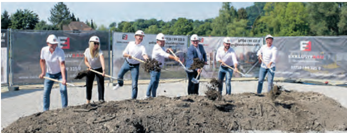
Beim symbolischen Spatenstich für das Projekt Aach-Aue auf dem einstigen Schiesser-Areal zwischen Singen und Rielasingen. Die Gemeinderäte Erwin Gräble und Saskia Frank, Exklusivbau Projektleiter Andreas Schirling, Geschäftsführer Viktor Kromm, Bürgermeister Ralf Baumert, Marketingleiter Daniel Repp und Vertriebsleiter Eduard Sachs. swb-Bild: of
