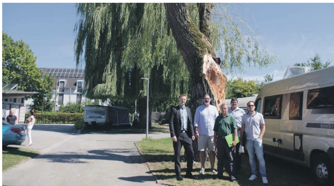
Beim Ortstermin auf dem Campingplatz Markelfingen: OB Simon Gröger, Pächter Matthias Kunz, Bausachverständiger Heinrich Holewa, Ortsvorsteher Lorenz Thum und der neue Leiter der Technischen Betriebe der Stadt Radolfzell, Ferdi Cihan.
