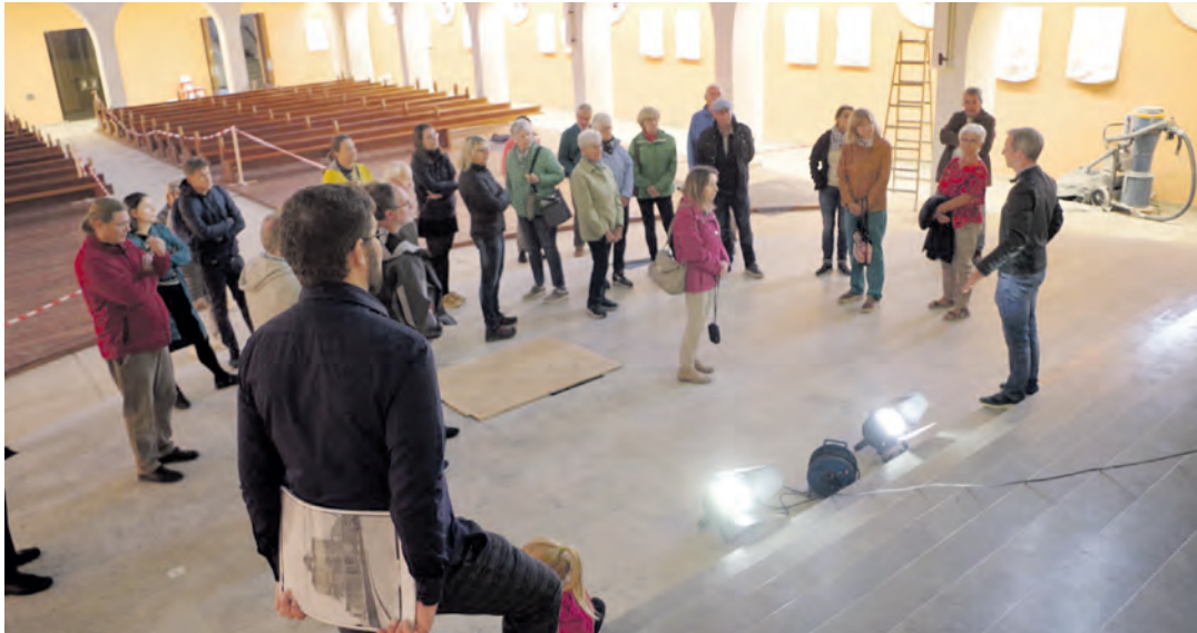
Viele interessante Einblicke bot die Museumsnacht in Stockach. Zum Beispiel in die Baustelle der Kirche St. Oswald, die noch bis zum Dezember Baustelle ist, aber schon viel von ihrer künftigen Gestaltung verriet. swb-Bild: of
