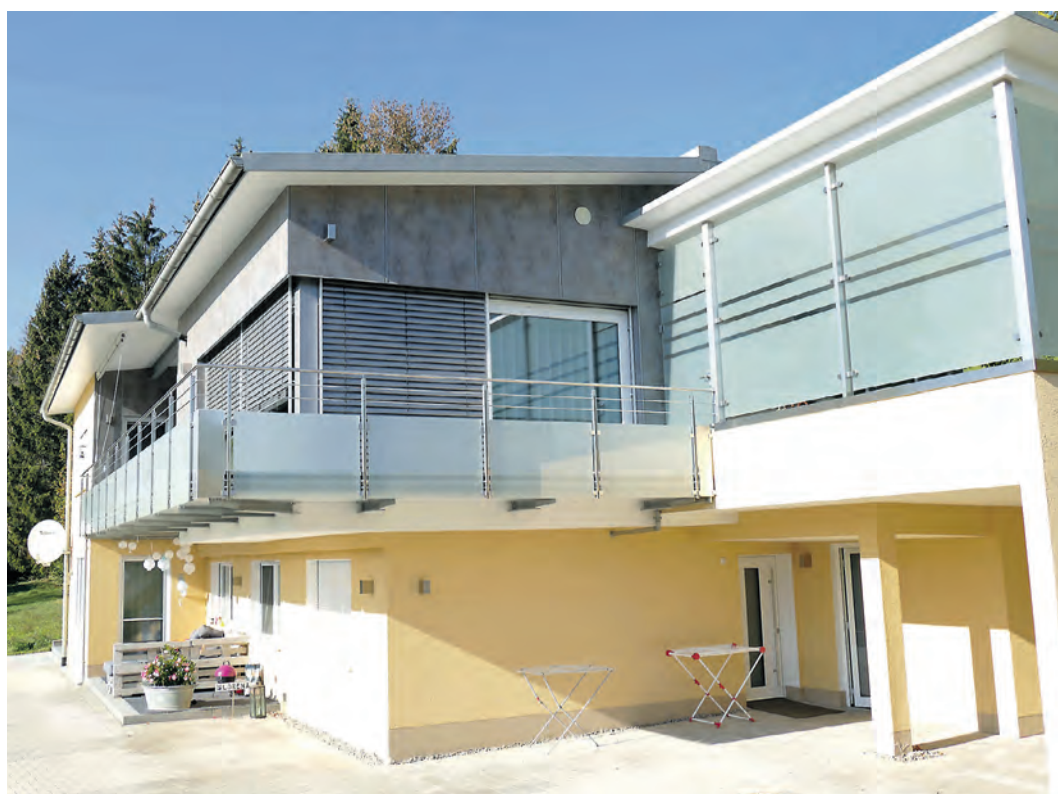
Umbau eines Einfamilienhauses.
