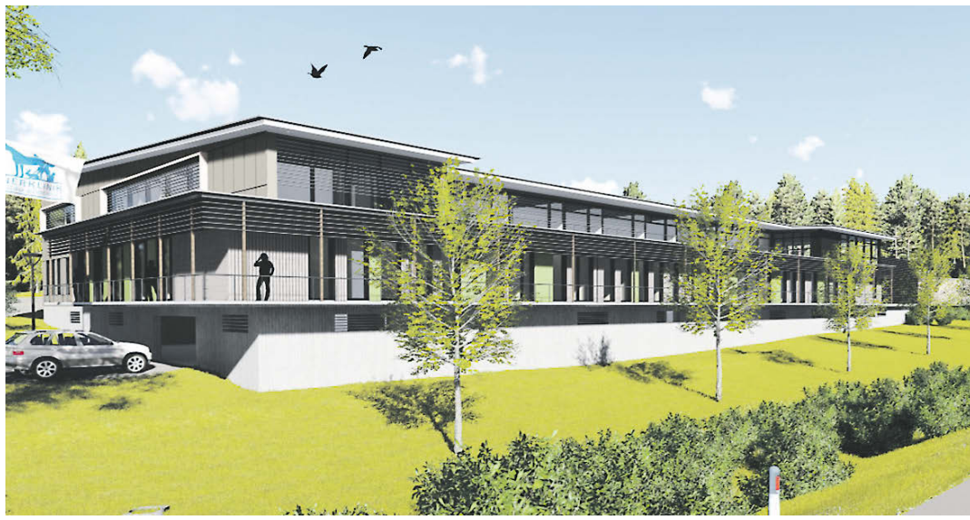
Am östlichen Ende des interkommunalen Gewerbegebiets Blumhof soll die neue Tierklinik nun entstehen. Prägend ist das dreigeschossige Gebäude der Kleintierklinik, das auf einer Tiefgarage erstellt wird, um die Hanglage zu überwinden. sub-Bild: Krämer Architekt
