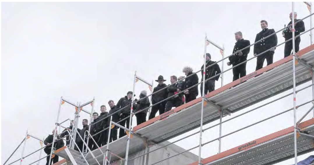
Die Mannschaft der Stockacher Zimmerei Kiefer zeigte sich mit dem kompletten Team windfest zum Richtspruch des WiGe-Projekts in Radolfzell. swb-Bild: of
