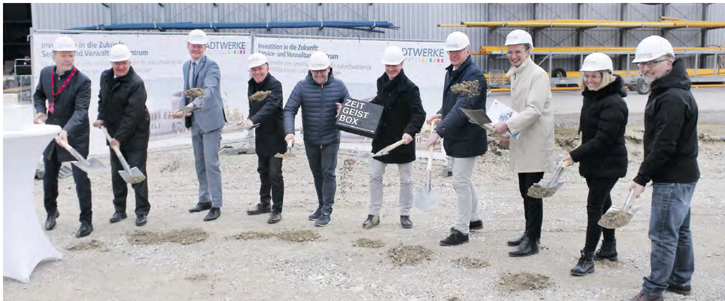
Mit vereinten Kräften ging es am Dienstagnachmittag an den Spatenstich für den Neubau des Dienstleistungszentrums der Stadtwerke Radolfzell. Zunächst ist eine sehr aufwändige Gründung des Bauprojekts nötig. swb-Bild: of
