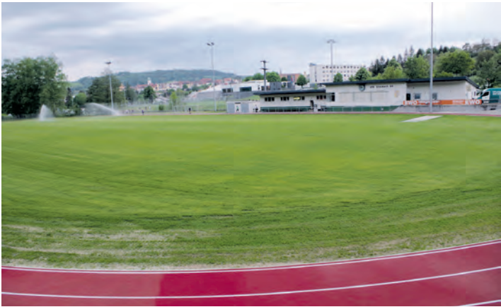
Seit Mai wächst der Rasen im sanierten Osterholz-Stadion. Nun kann nach einem Jahr Bauzeit am kommenden Samstag Einweihung gefeiert werden.
