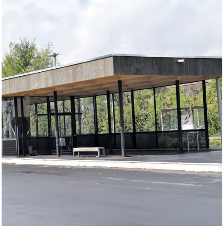
Die letzten Teile fehlen zwar noch aufgrund von Lieferengpässen, aber das Fahrradhaus am Gottmadinger Bahnhof soll noch in diesem Jahr eingeweiht werden. swb-Bild: Ute Mucha
