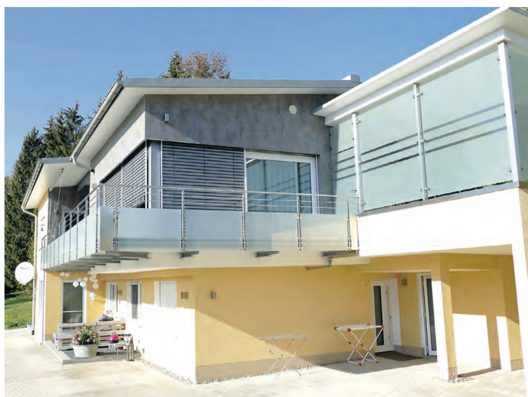
Umbau eines Einfamilienhauses.
