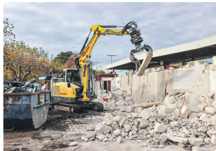
Die Abrucharbeiten sind am Dienstagmittag bereits in vollem Gange. swb-Bild: Anja Kurz
