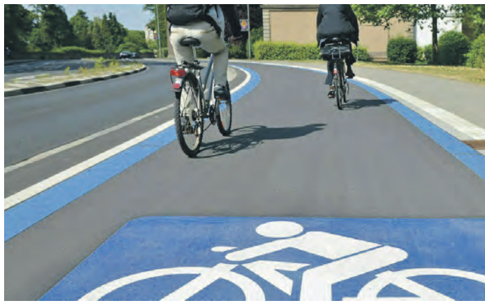
Der Radschnellweg von Konstanz nach Radolfzell wird nicht nur wegen dem Geld noch länger warten müssen, denn die B33-Baustelle steht dem 30-Millionen-Euro-Projekt auch im Weg.
