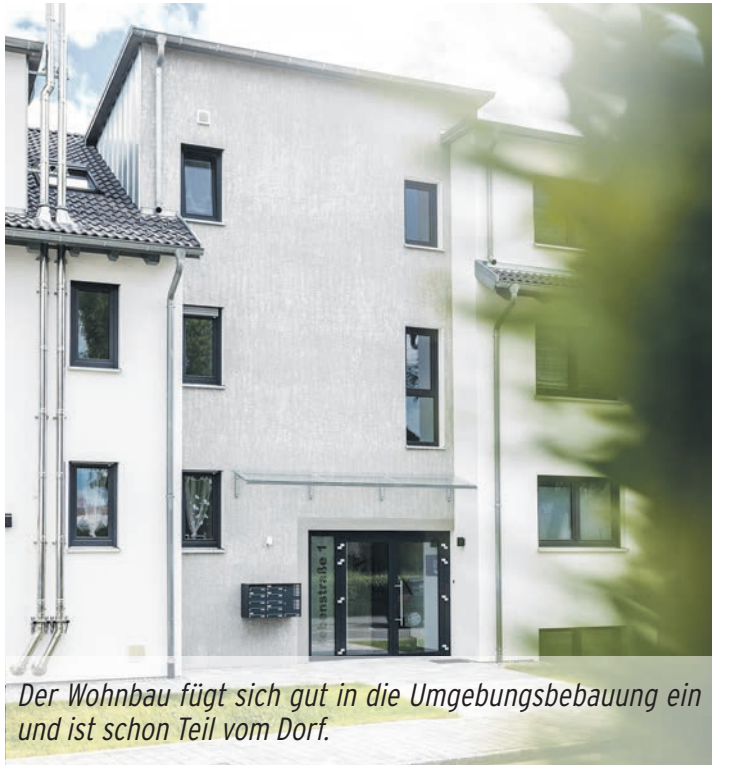
Kaum zu glauben, dass in dem Gebäude vier Geschosse genutzt werden können, mit Terrassen und Balkonen auf der Sonnenseite.
