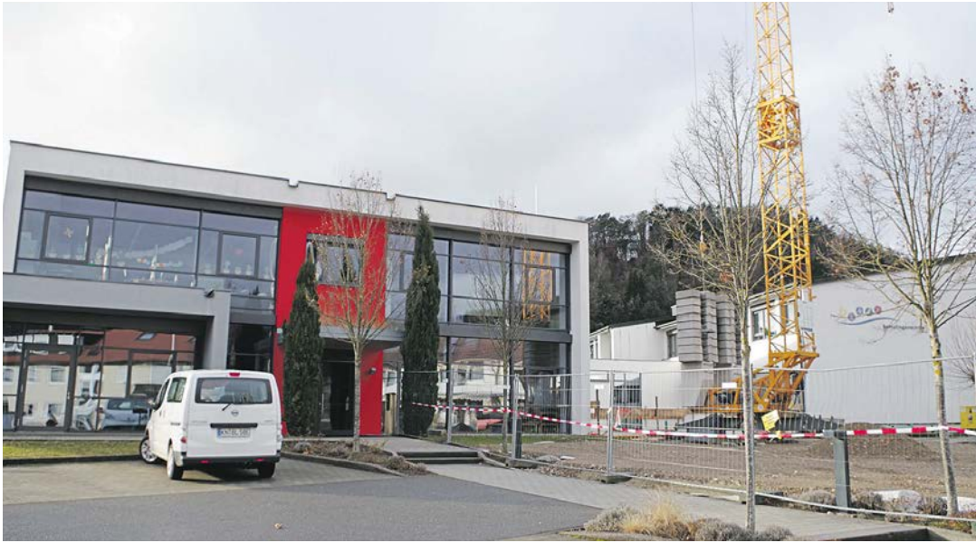
Seit November laufen die Bauarbeiten für den Mensa-Neubau an der Sernatingen-Schule, der Platz für die Zwischennutzung durch den Kindergarten dort bietet. swb-Bild: of
