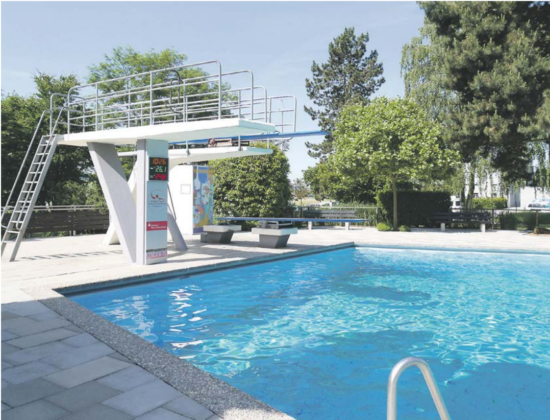
Das Hilzinger Familienbad ist in die Jahre gekommen und soll saniert werden. Eine erste Studie für notwendige Maßnahmen wurde nun in Auftrag gegeben.
