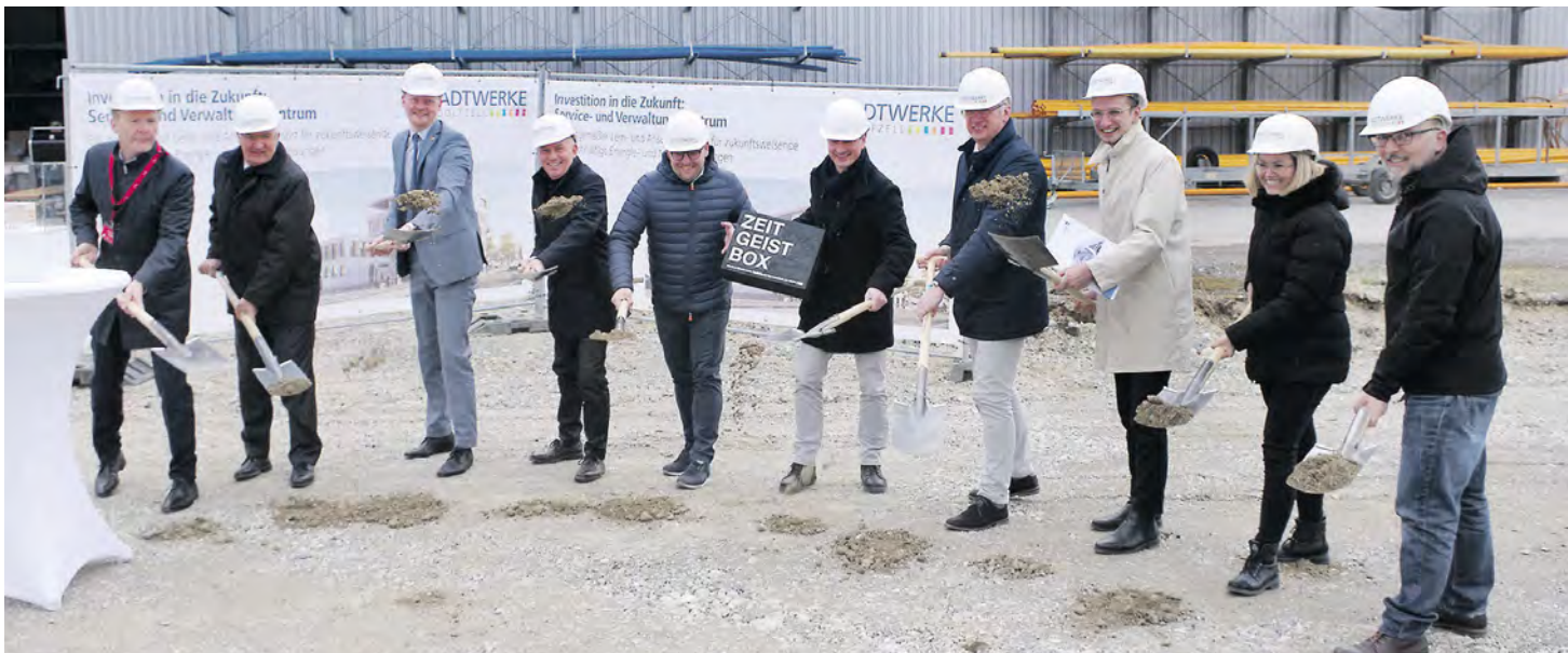
Mit vereinten Kräften ging es am Dienstagnachmittag an den Spatenstich für den Neubau des Dienstleistungszentrums der Stadtwerke Radolfzell. Zunächst ist eine sehr aufwändige Gründung des Bauprojekts nötig.
