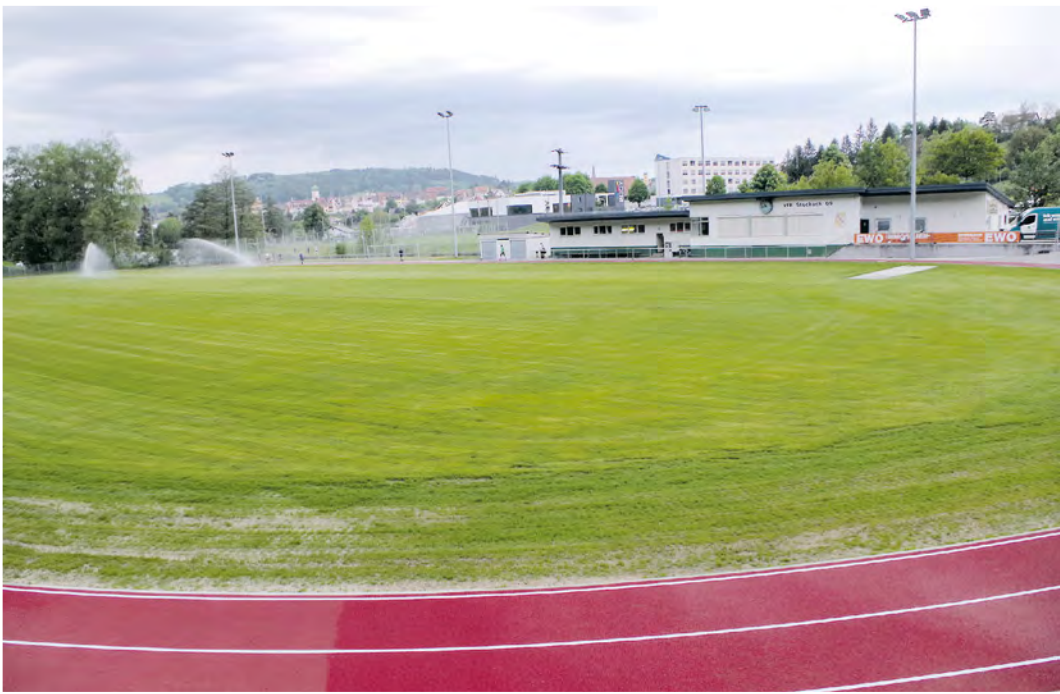
Das von Grund auf erneuerte Spielfeld des Osterholz-Stadions vor der Stadtkulisse. Im Bild auch die neue Laufbahn.
