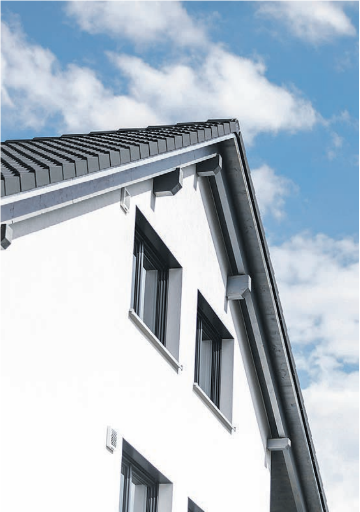
Insgesamt 11 Wohnungen haben mit unterschiedlichen Ausmaßen in dem Neubau an der Rebenstraße in Beuren Platz gefunden.
