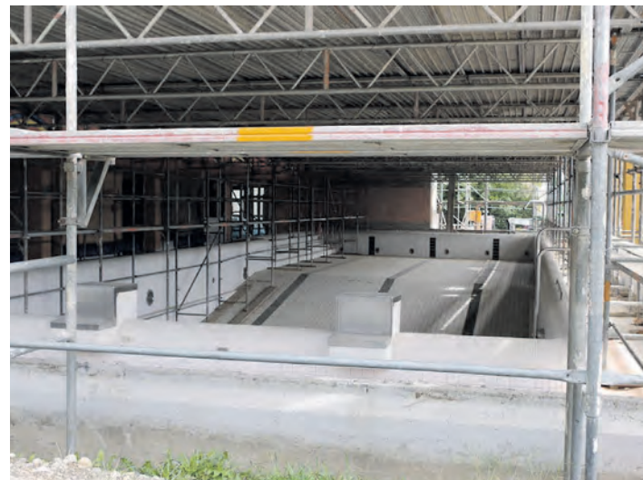
Für die Bädersanierungen der Stadtwerke Stockach steuert die Stadt in 2023 weitere zwei Millionen Euro bei. Im Bild die Baustelle Hallenbad im Herbst.
