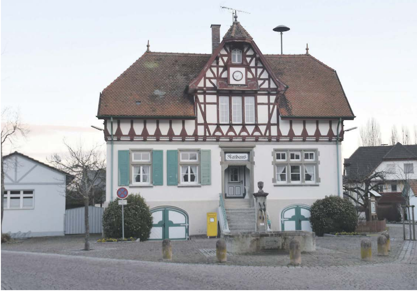
Das alte Rathaus in Iznang soll saniert und weiterhin von den örtlichen Vereinen genutzt werden.
