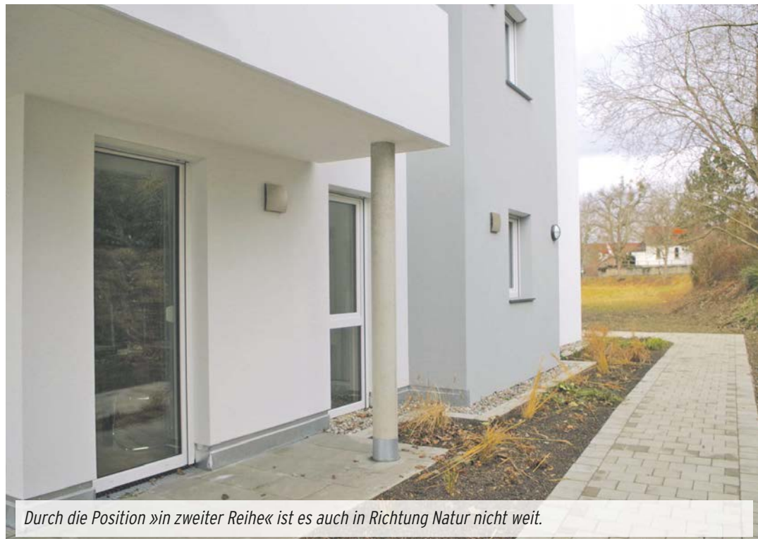
Auf dem Dach sind eine Anlage zur Solarthermie wie eine Photovoltaikanlage installiert, die das Gebäude dabei unterstützen, sich mit Wärme und Strom selbst versorgen zu können. swb-Bilder: of
