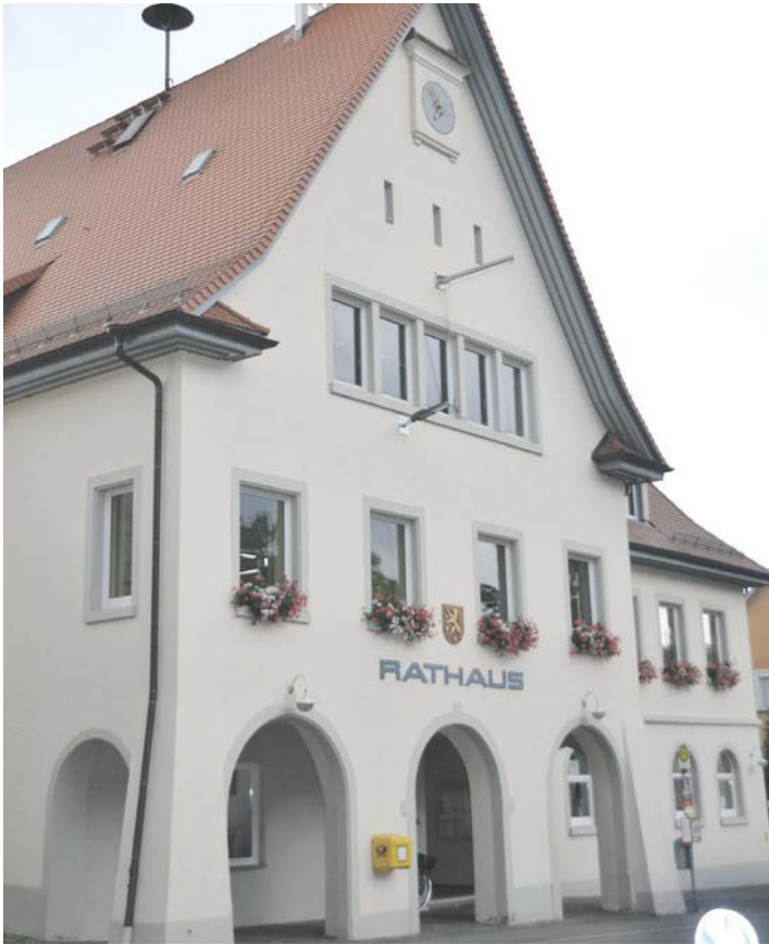
Das Rathaus in der Aacher Ortsmitte soll modernisiert und barrierefrei umgebaut werden.
