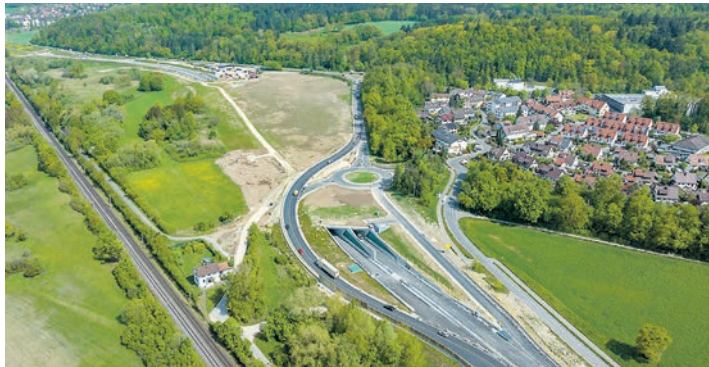
Der nun vor der Verkehrsfreigabe stehende Tunnel der B 33 bei Reichenau Waldsiedlung entschärft einen entscheidenden Knotenpunkt an der Strecke.
