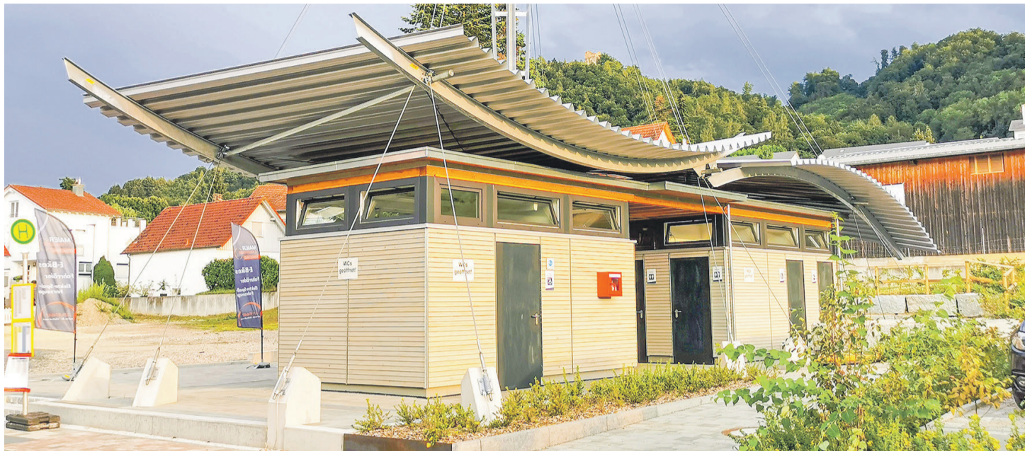
Der „Mobility Hub“ am Parkplatz Kapelle in Bodman wurde vor wenigen Wochen baulich fertiggestellt. Hier ist der Startpunkt des „City-Trains“ geplant. swb-Bild: Oliver Fiedler
