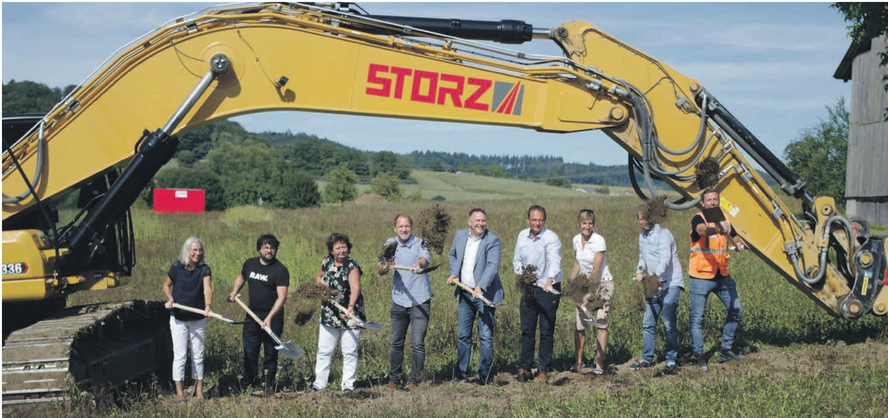
Nach dem Spatenstich begannen die Bauarbeiter des Unternehmens Storz unmittelbar mit ersten Abschiebearbeiten am neuen Eigeltinger Baugebiet Bollenberg Nord.
