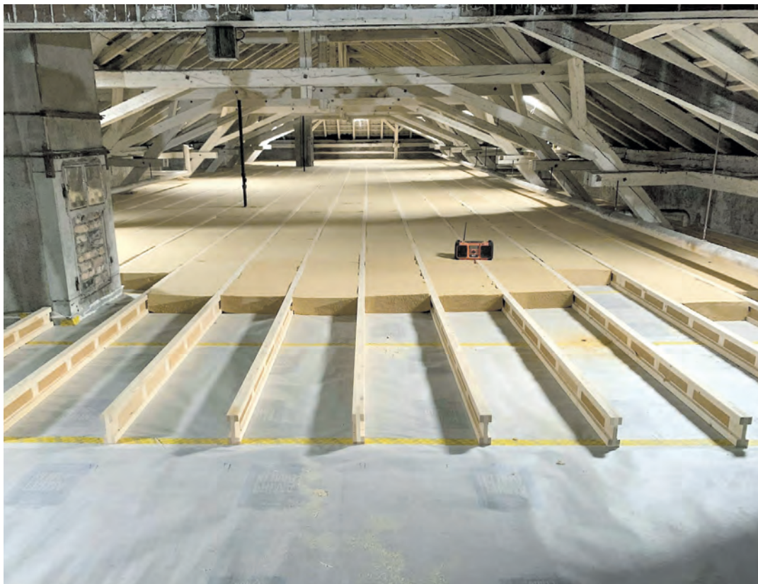
Der ca. 800 qm große Speicher des denkmalgeschützten Gebäudes wird nachhaltig saniert. Die Energieeinsparungen durch diese Maßnahme belaufen sich auf ca. 56.000 kWh pro Jahr.
