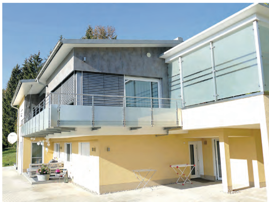
Umbau eines Einfamilienhauses.
