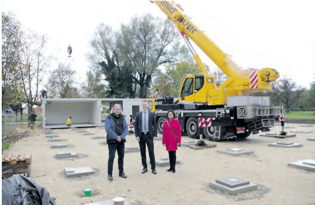
Joachim Wiedmann, OB Simon Gröger und Bürgermeisterin Monika Laule an der Baustelle für den Containerkindergarten an der Hebelstraße. Bis Dienstag sollen alle Container aufgestellt sein.
