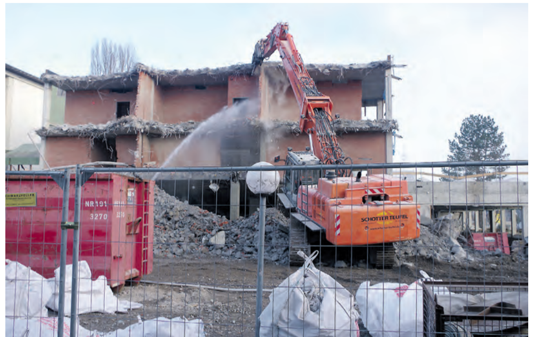
Mit den kräftigen Zangen des Spezialbaggers müssen die massiven Decken aus Stahlbeton förmlich zerkrümelt werden. Der Schutt wird später noch zwischen den mineralischen und metallischen Anteilen aufgetrennt.
