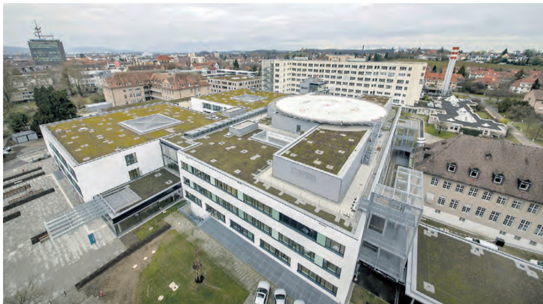
Das Konstanzer Klinikum wurde erst Anfang 2018 fertiggestellt, die Entscheidung dazu fiel freilich schon vor der Fusion zum Gesundheitsverbund. Zumindest die neuen Teile des Klinikums werden zu neuen Schwerpunkten geformt, für die älteren Gebäude besteht auch ein Sanierungsstau.
