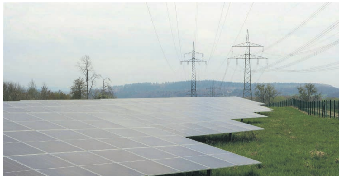
In Gottmadingen werden Standorte für eine oder mehrere Solaranlagen geprüft. Symbolbild/Archiv
