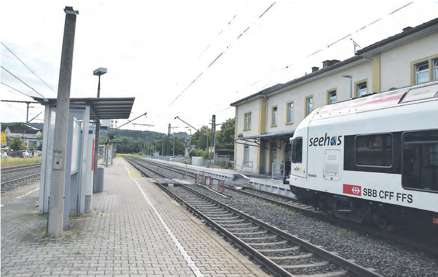
Am Bahnhof Engen ist nicht nur das Gebäude sanierungsbedürftig. Durch die Verzögerung der Arbeiten der Deutschen Bahn ist die Stadt allerdings in ihren Möglichkeiten eingeschränkt.
