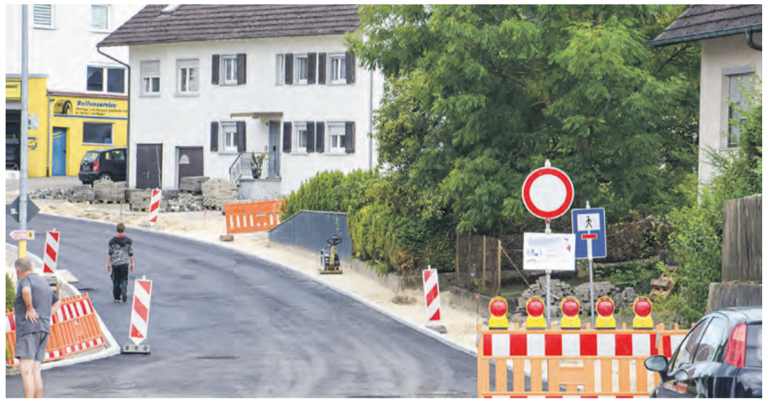
Hier geht's weiter mit den Bauarbeiten: Bis nächsten Sommer soll die Ortsdurchfahrt in Mühlhausen fertig saniert und wieder frei befahrbar sein. sub-Bild: Ute Mucha
