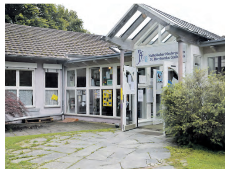
In Zukunft soll in Gailingen mit dem Neubau eines Kindergartens eine weitere Sanierungsmaßnahme folgen, wofür der Katholische Kindergarten St. Bernhardus weichen müsste.
