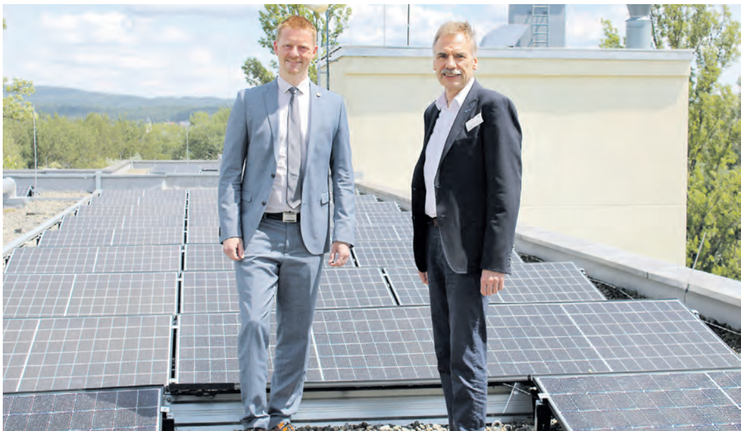
Radolfzells Oberbürgermeister Simon Gröger und Eckhard Scholz, Mettnau-Geschäftsführer und Kurdirektor, freuen sich über die neuen Photovoltaikanlagen.
