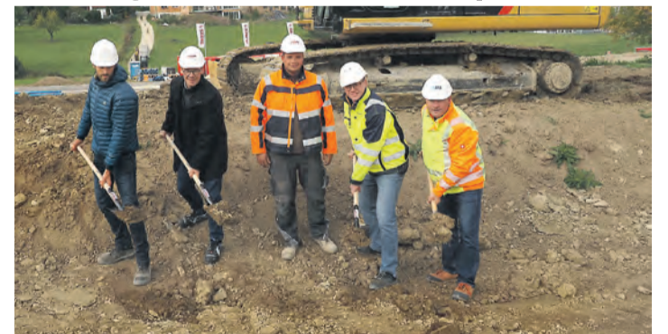
Beim symbolischen Spatenstich Patrick Stadler vom Planungsunternehmen Reckmann, Bürgermeister Thorsten Scigliano, Kevin Klein vom Tiefbau-Unternehmen Storz, Alexander Joos von Netze BW und Matthias Ventz von BLS. sub-Bild: Oliver Fiedler
