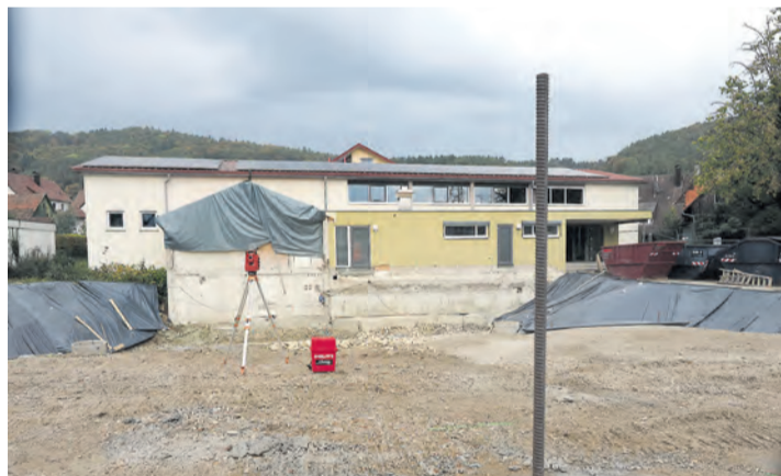
Die Testpfähle auf der Baustelle für den neuen Kindergarten in Ludwigshafen ergaben, dass die Erde tief unter der Bodenplatte keinen Halt mehr bietet. swb-Bild: Oliver Fiedler
