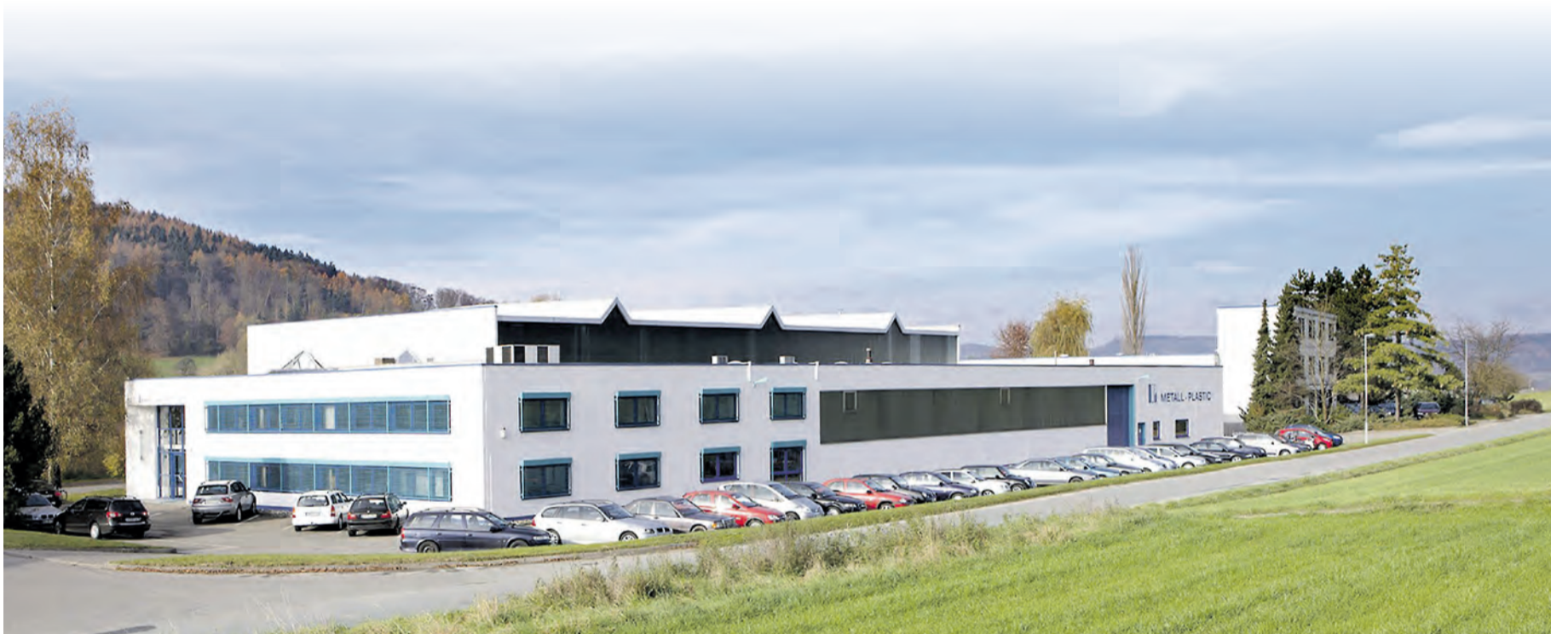
So sah das Betriebsgebäude vor der Sanierung aus. Noch an der Fassade zu sehen: die Aufschrift Metall+Plastic.
