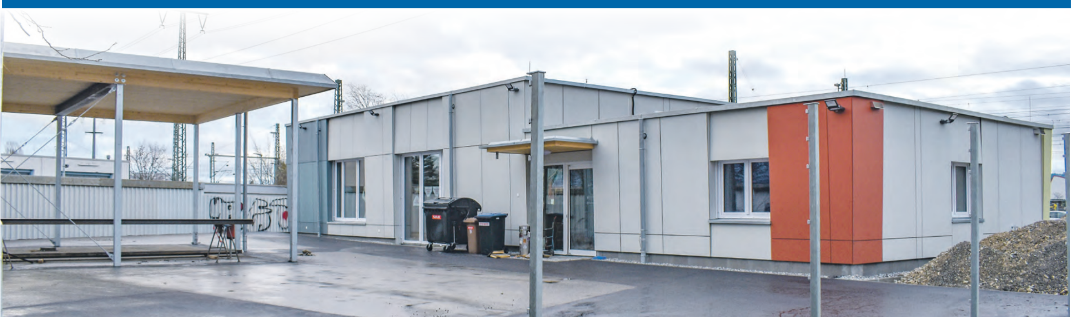
Der Neubau für die Teestube mit der Überdachung für eine Skateranlage.
