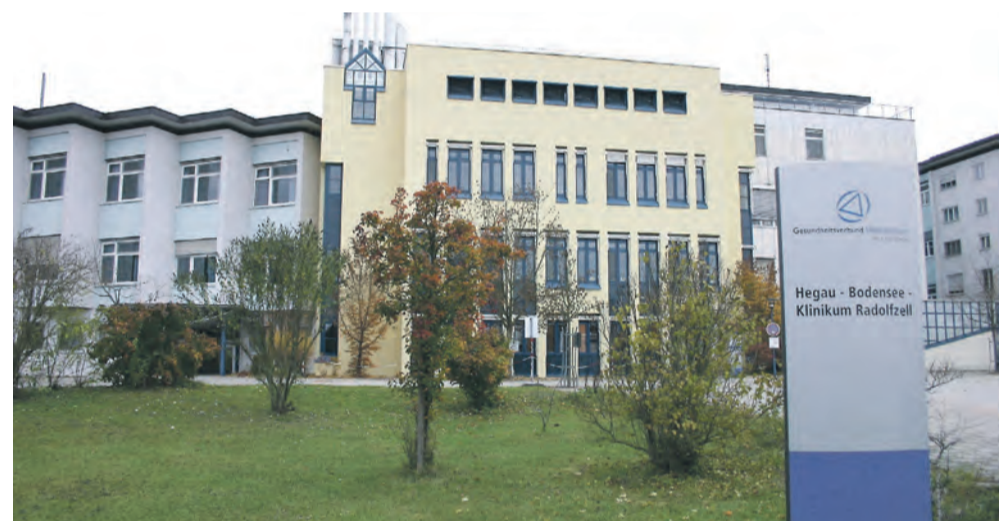
Aus und Schluss für das Radolfzeller Krankenhaus: der Aufsichtsrat des Gesundheitsverbund des Landkreis Konstanz hat Anfang Februar 2023 die Schließung auf den 30. Juni beschlossen. Hohe Verluste durch Personalmangel, bauliche Mängel und auch ein riesiger Sanierungsstau hätten zu diesem drastischen Schritt gezwungen. swb-Bild: Archiv/SWB
