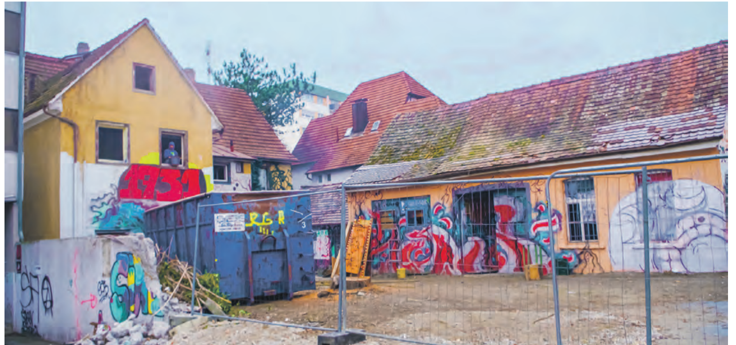
Eher an der Rückseite der ehemaligen Teestube sind aktuell die Vorbereitungen zum Abriss sichtbar. Ein Baubeginn für die Nachfolgebauung am Blockrand ist auf Sommer vorgesehen.
