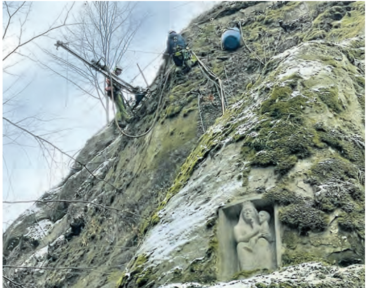
Im Dezember wurden mit Hubschrauberunterstützung die Anker für Steg durch die Marienschlucht eingepresst.
