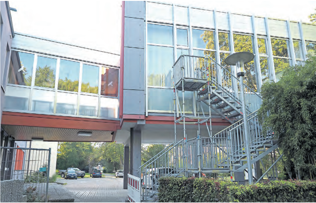
Die am Ratssaal angebaute provisorische Treppe ist nur ein Dokument mangelhaften Brandschutzes im Rathaus von Rielasingen-Worblingen. Deshalb soll nun ein möglicher Neubau vorbereitet werden. swb-Bild: Oliver Fiedler
