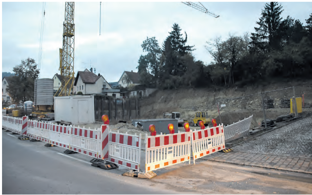
Die Bauarbeiten auf dem Kroneareal haben bereits begonnen und sollen im besten Fall Ende 2024 abgeschlossen sein.
