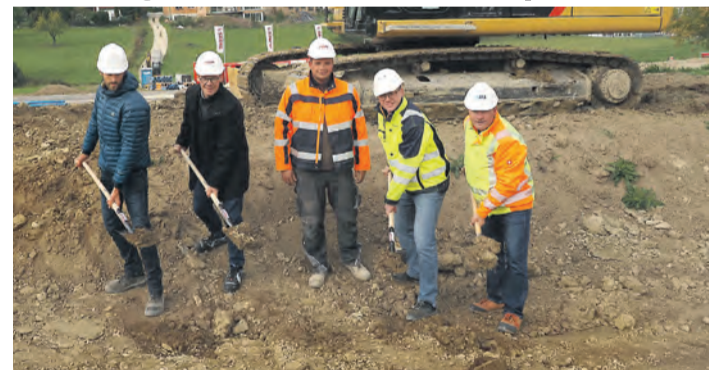
Beim symbolischen Spatenstich Patrick Stadler vom Planungsunternehmen Reckmann, Bürgermeister Thorsten Scigliano, Kevin Klein vom Tiefbau-Unternehmen Storz, Alexander Joos von Netze BW und Matthias Ventz von BLS. sub-Bild: Oliver Fiedler
