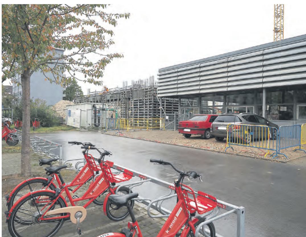
Das neue BSZ Konstanz, für das der erste Abschnitt im letzten Sommer begonnen wurde, ist der große Schwerpunkt der Investitionen des Landkreises im kommenden und den folgenden Jahren.
