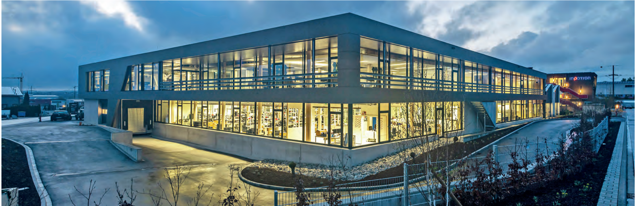
Außen wie Innen: Hightech, Transparenz, Wärme
