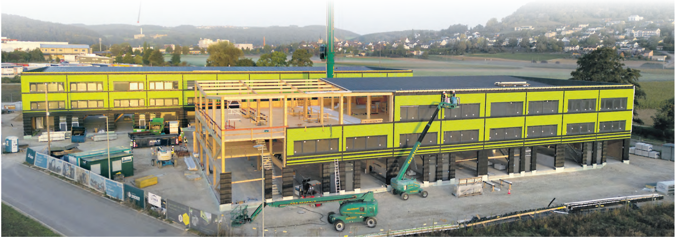
Die Bauarbeiten an den Green Places in Bietingen sind fast abgeschlossen. Schon im Januar sollen die ersten Mieter und Käufer einziehen.
