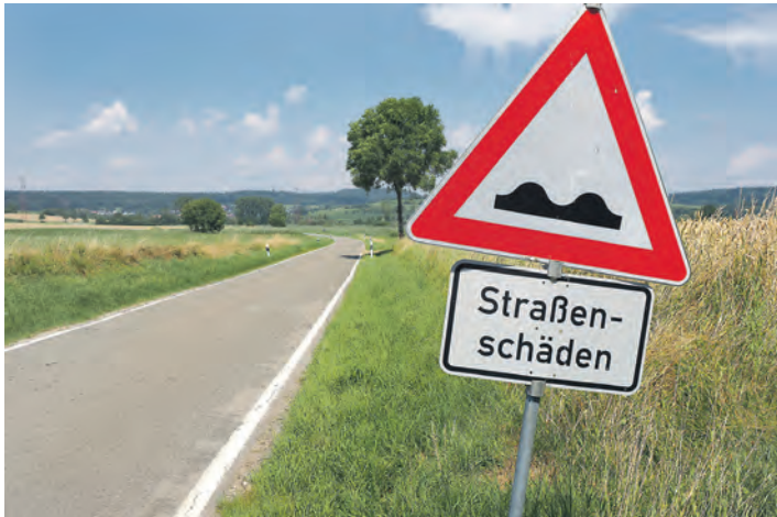
Ausgemergelt, voller Schlaglöcher und Bodendellen. Die Kreisstraße zwischen Heudorf und Raihaslach soll durch den Landkreis gesperrt und aufgegeben werden. swb-Bild: Oliver Fiedler
