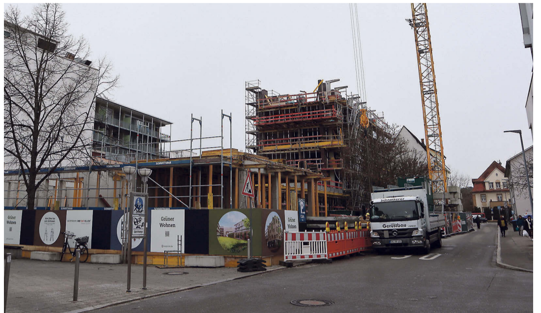
Eines der Neubauprojekte in Singen, hinter der C&A-Filiale.
