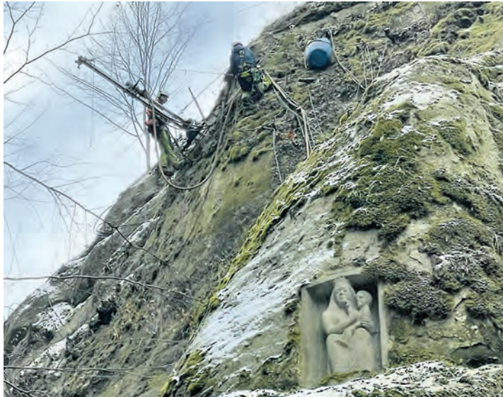
Im Dezember wurden mit Hubschrauberunterstützung die Anker für Steg durch die Marienschlucht eingepresst. swb-Bild: Weckbach
