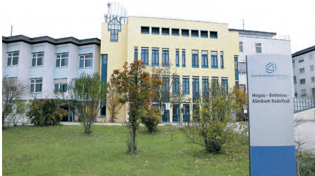
Das Radolfzeller Krankenhaus wurde mehrfach erweitert, vieles passte nicht zusammen. Weil der Gesamtbau inzwischen einen so hohen Sanierungsbedarf hat und schon Teile des Gebäudes aus Gründen des Brandschutzes gar nicht mehr genutzt werden können, zog der Aufsichtsrat des Klinikverbunds nun die Reißleine und will das Krankenhaus auf den 30. Juni schließen.
